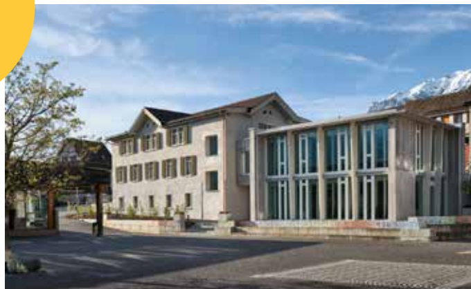
Das sanierte Escherhaus Malans
