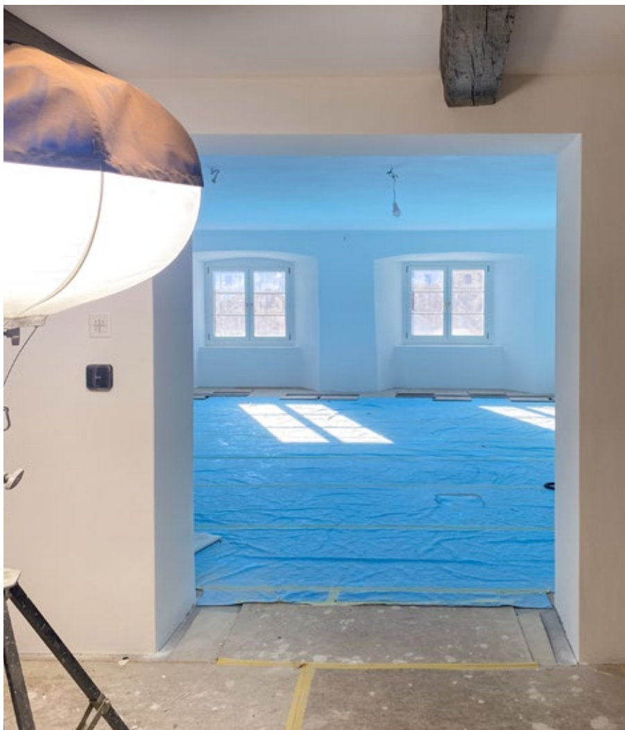
Neuer Eingangsbereich Gemeindeverwaltung im OG des Rathauses
