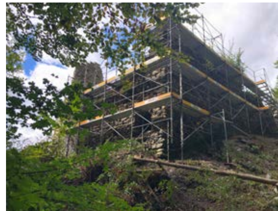
Baugerüst entlang der bergseitigen Aussenmauer und der talseitigen Südostecke
